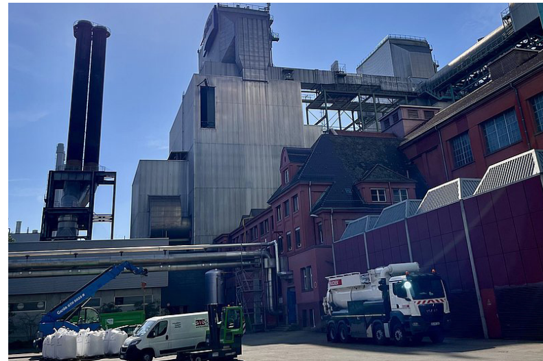
Exkursion der BNRE-Studierenden zu einem Heizkraftwerk der Zukunft
