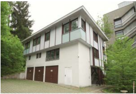
LSC im Gebäude hinter W1
