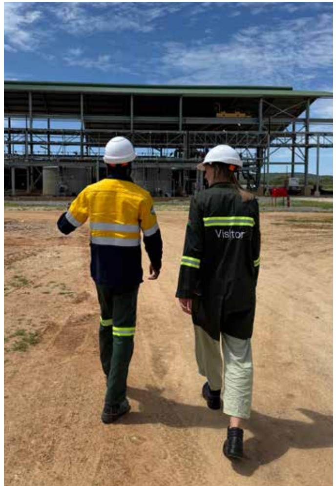
Führung durch die Aufbereitungs-Prozesse, welche durch die im Hintergrund ablaufende Elektrolyse zu reinem Kupfer abgeschlossen werden
