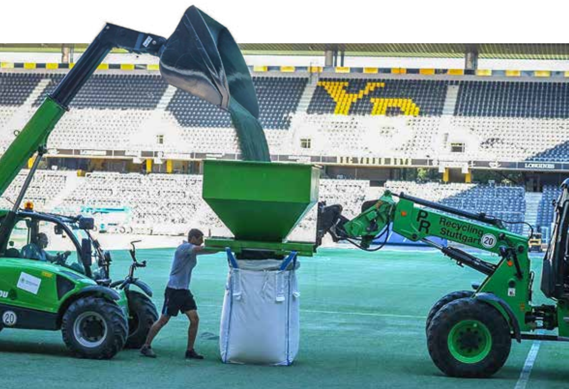
Recycling vor Ort mit der Trennung des Sandes und Performance Infills von den aufgerollten Kunststoffrasenbahnen. Bildrechte: Deimling, PR-Recycling.
