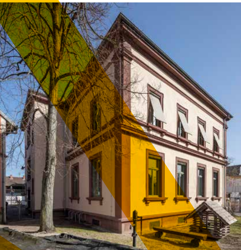
Abbildung 1: Daxlanden mit Sonnenschutz Fallarmmarkisen an der Federbachschule in Karlsruhe. Foto: Atelier Altenkirch
